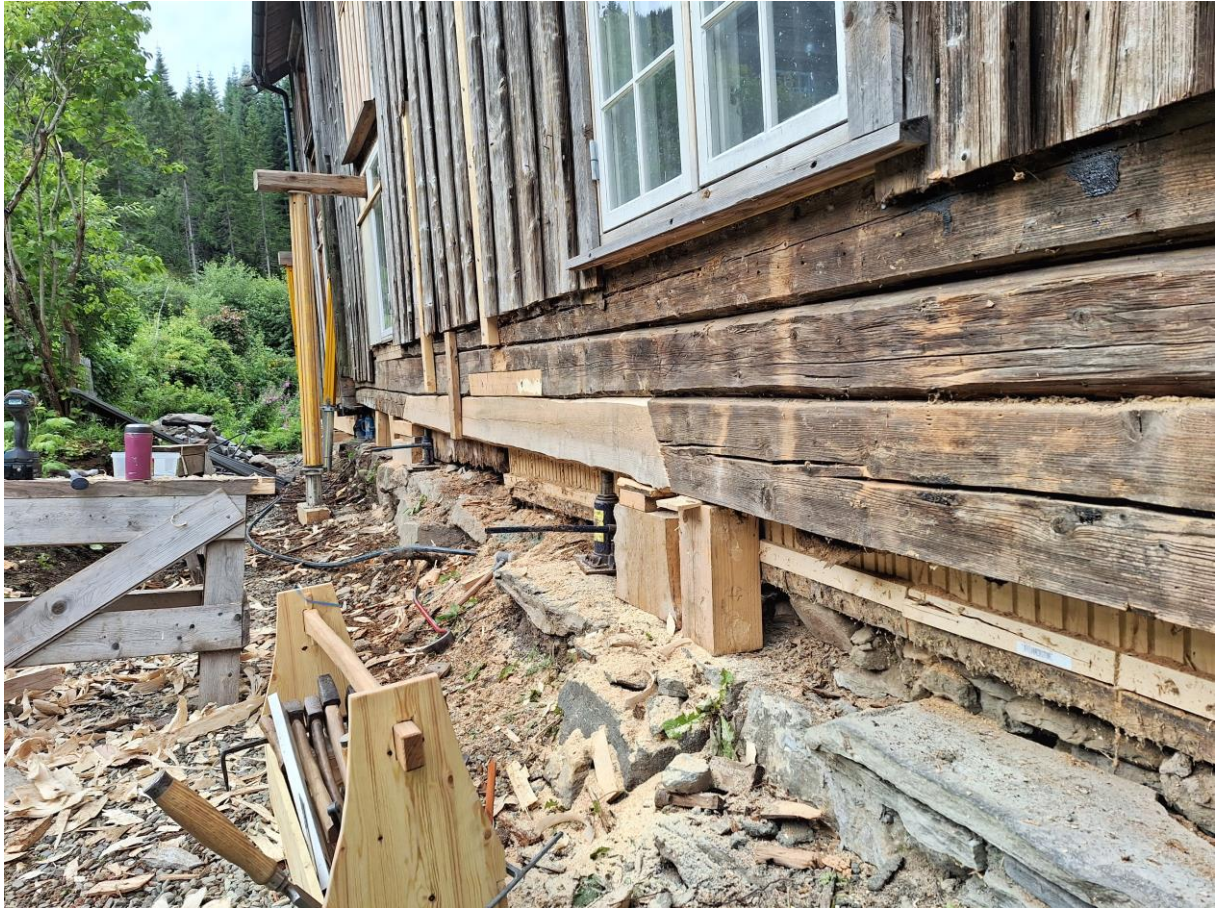
Sydvegg. Panel ble demontert, betong ble meislet bort, og vi skiftet laft der det var råteskader.
