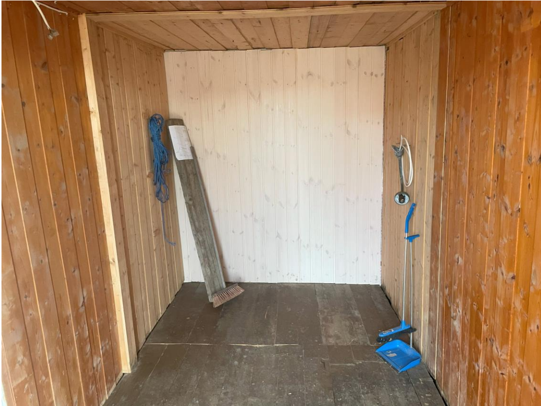
Bislag med nytt gulv og nytt panel på en vegg.
