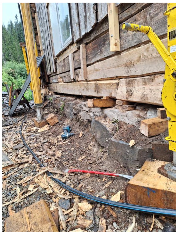
Sydvegg. Panel ble demontert, betong ble meislet bort, og vi skiftet laft der det var råteskader.
