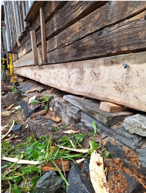
Sydvegg. Panel ble demontert, betong ble meislet bort, og vi skiftet laft der det var råteskader.
