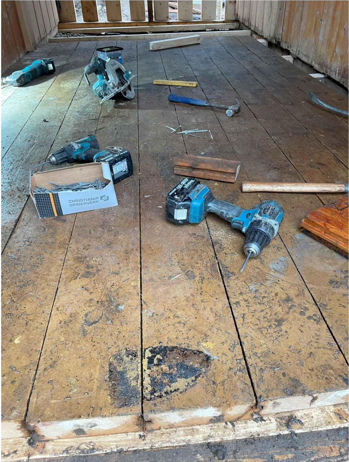
Bislaget fikk tidsriktig 2" gulv. Dette gulvet lå en gang i et bolighus på Mellomila.
